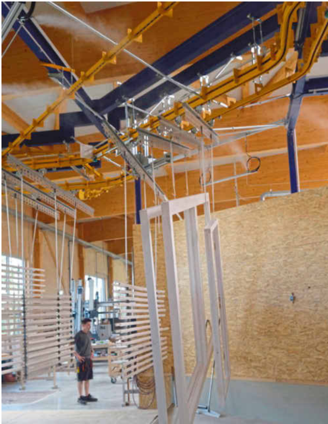
Abtropfzone mit Hochdruckbefeuchtung und Teileschrägstellung
