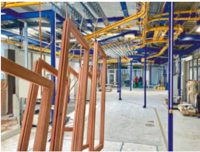
/ Die Herausforderung bestand in der Planung und Umsetzung der Integration der neuen Roboterlackieranlage in den seit 2017 betriebenen Flutkreislauf.
