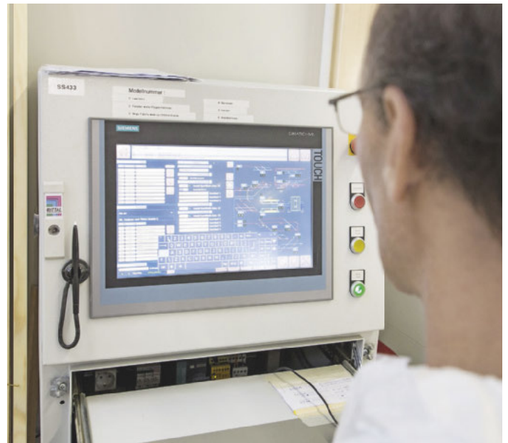
/ Leitrechner unterstützen aktiv komplexere Beschichtungsprozesse. Die Mitarbeiter können sich in vielen Fällen auf die Prozessüberwachung konzentrieren.
