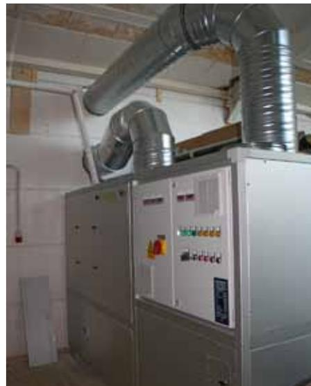
**Herzstück der Trocknung:** Die Hygrex-Anlage punktet mit Energieeinsparung – der Trockner funktioniert wie eine Wärmepumpe
