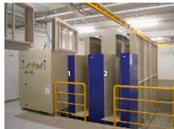
**Zwei Kabinen:** Grundierung mit wechselnden Farben (1), immer transparenter Zwischengrund (2)
